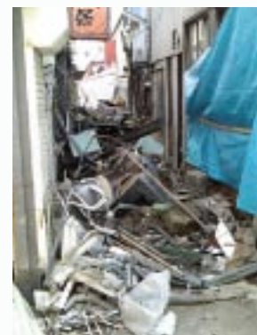
被災した自販機設置場所 (石巻市)
