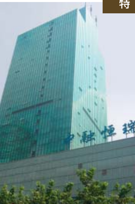
上海本社の入っているビル
