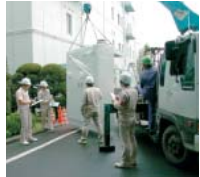
安全衛生パトロール
